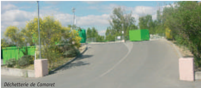
Déchetterie de Camaret
