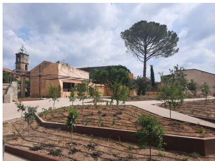
Aménagement du centre-ville de Sérignan-du-Comtat
