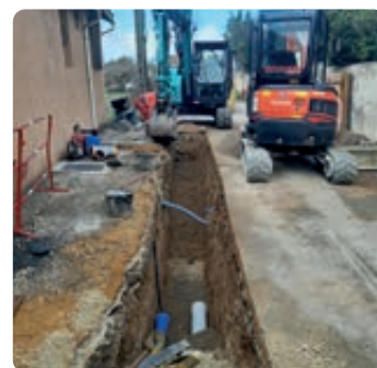
Chantier Moricaud - Piolenc.
