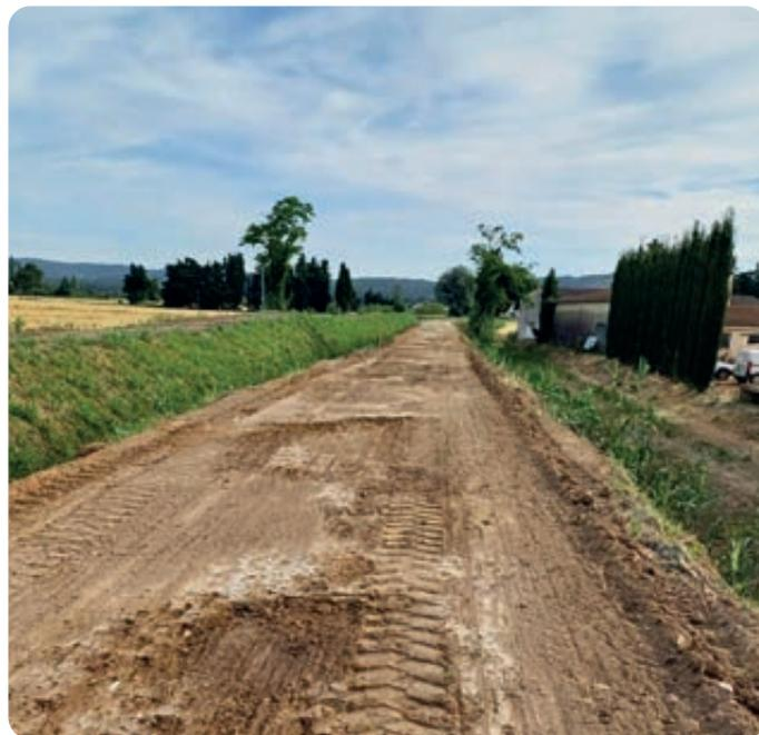
Réfection intégrale de la digue du Rieu Foyro entre l'autoroute A7 et la station d'épuration
