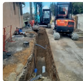
Chantier Moricaud - Piolenc.
