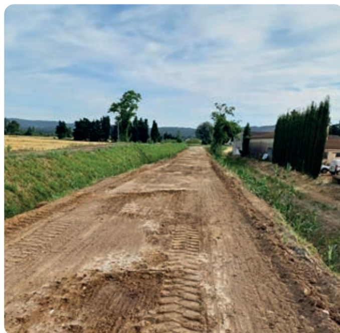
Réfection intégrale de la digue du Rieu Foyro entre l'autoroute A7 et la station d'épuration
