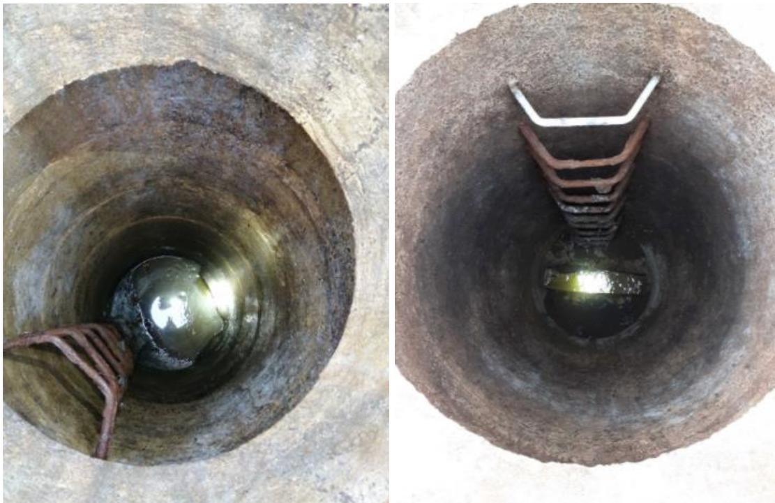
**FIGURE 17 : Traces de mise en charge rue du 19 mars 1962 (Source : EGIS)**
