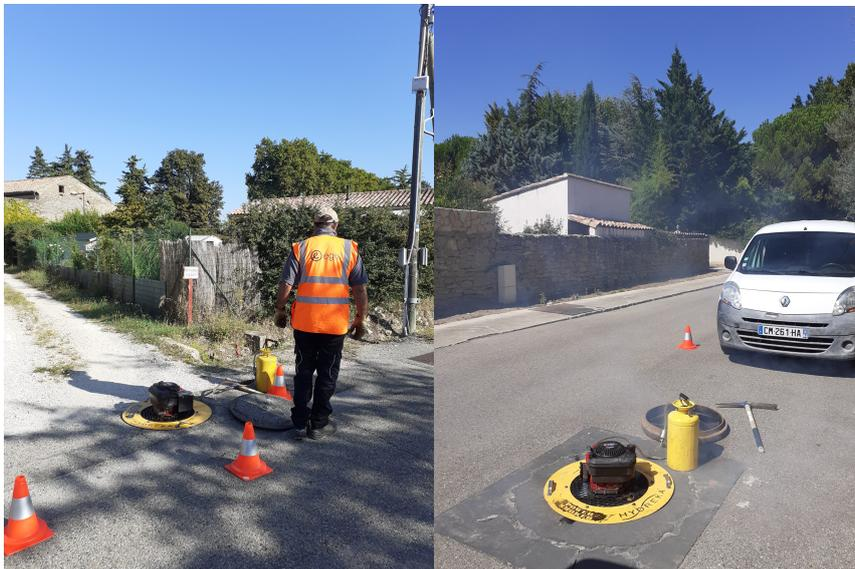
Figure 1 : Réalisation des tests a la fumée (Source : Egis)
