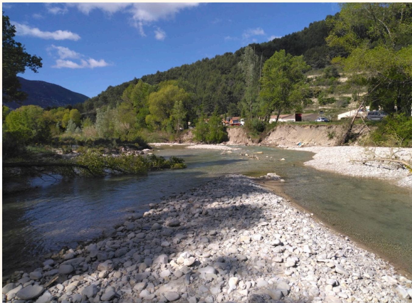
Erosion en rive droite à proximité de la route départementale
